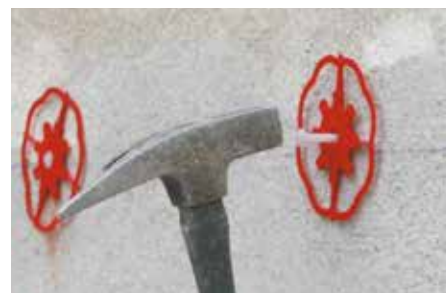
Baunit pritrdilna sidra vstavimo v izvrtano luknjo ter pritrdimo z zabijanjem ali vijačenjem
