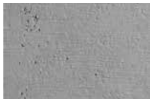
videz grobega betona
