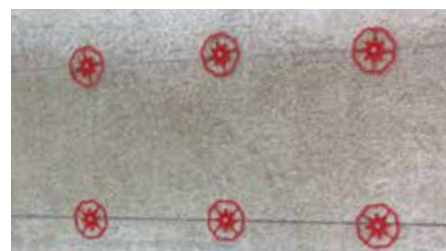
Baunit pritrdilna sidra postavljamo po shemi mreže, maksimalno 40 x 40 cm.
