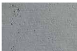
videz grobega betona
