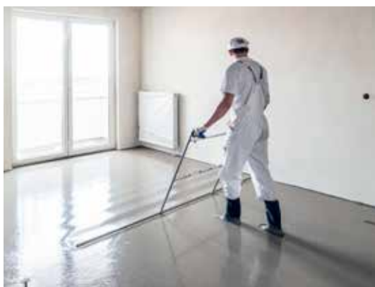
Odzračevanje samorazlivnega estriha
