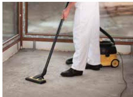
Pred polaganjem vezanega estriha je potrebno odstraniti vse nečistoče iz podlage
