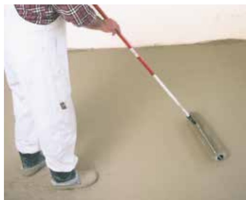
Odzračevanje samorazlivne mase z bodičastim valjčkom
