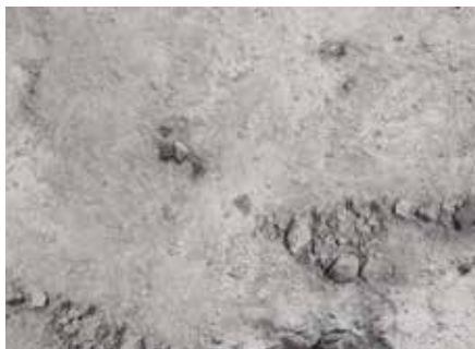
Odstraniti je potrebno vse neravnine in nečistoče
