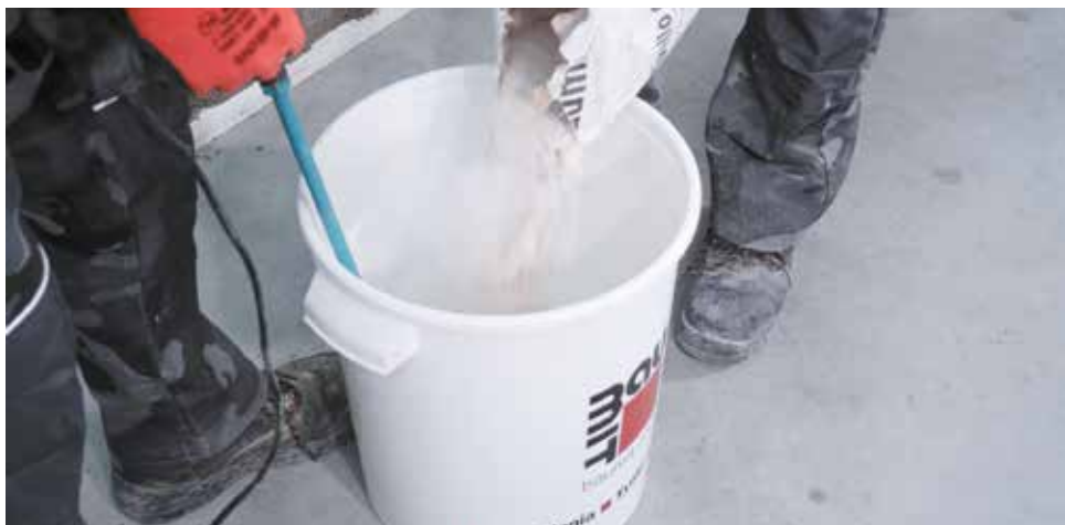
Priporočen nastavek za mešalnik za samorazvalne mase
