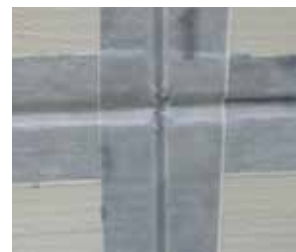
Izvedba s tesnilnim trakom
