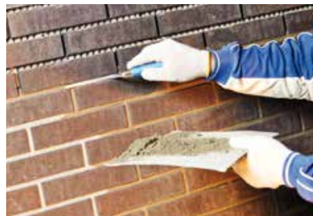
Fugiranje s fugirno žlico
