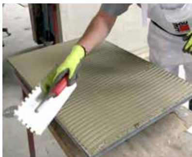
Lepljenje po sistemu „floating-buttering“ z Baunit CeramicFix
