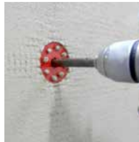
Sidranje z Baumit vijječnim sidrom
