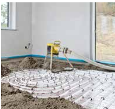
Slika 16: Vgrajevanje estriha
