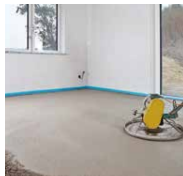
Slika 18: Strojno glajenje
