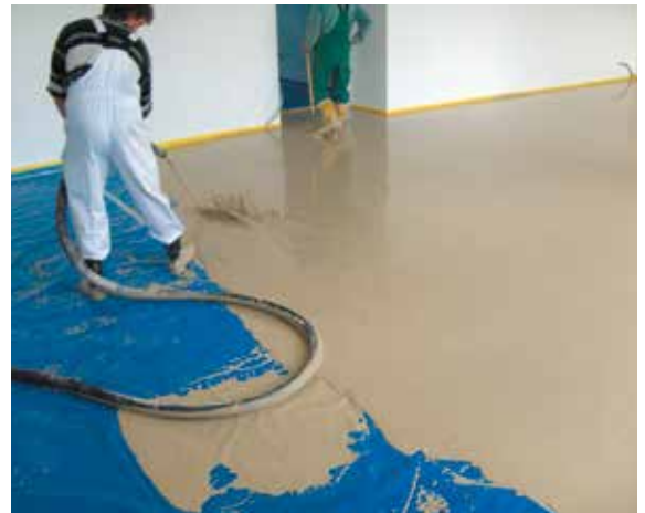
Slika 2: Vgrajevanje Baunit Alpha 2000 na parno zaporo
