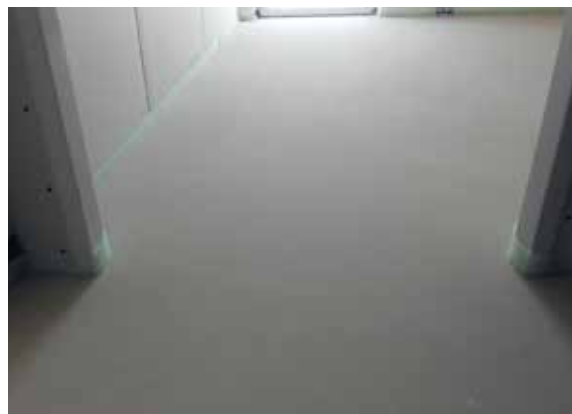
Slika 4: Dilatacija pri Baunit Alpha 2000
