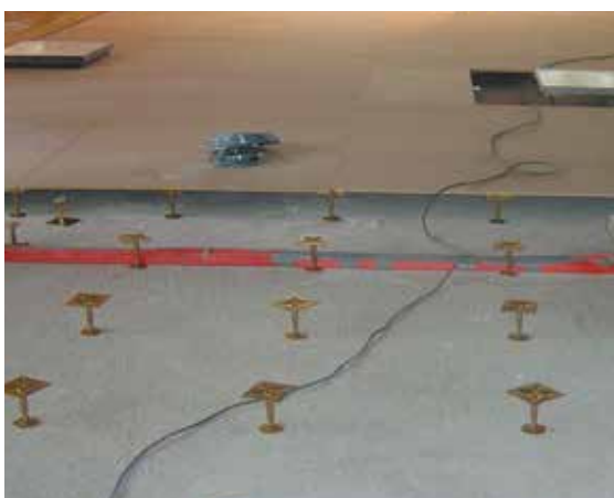
Slika 5: Priprava dvignjenih tal
