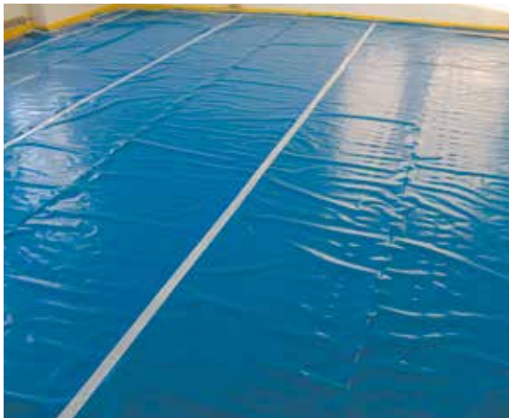
Slika 1: Prekrivanje in lepljenje PE-folije
