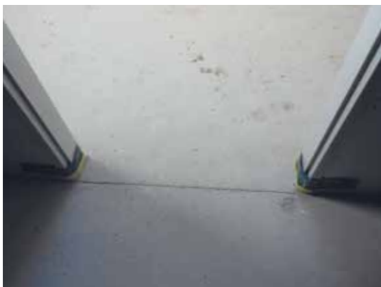
Slika 3: Dilatacijska pri Baunit Estrich E 225
