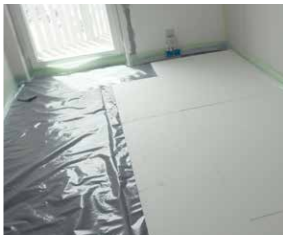
Slika 12: Parna zapora (folija) z zvočno izolacijo EPS-T
