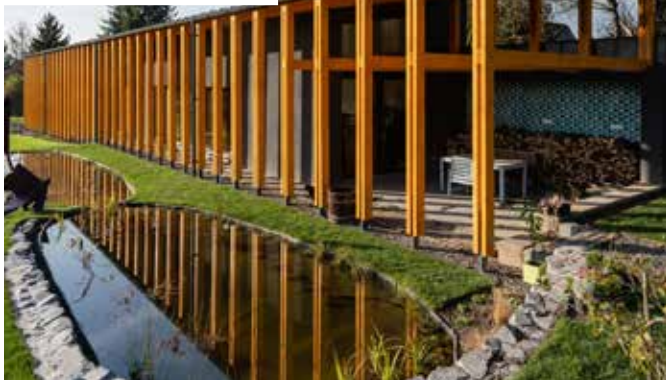
Longitudinal-Axis Home, Budakeszi (Madžarska)
