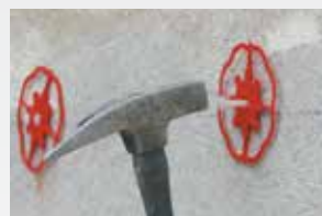
Baumit pritrdilna sidra vstavimo v izvrtano luknjo ter pritrdimo z zabijanjem ali vijačenjem
